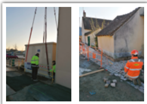
Pose du nouveau transformateur ENEDIS et pose des pavés dans les rues des Miracles et de la Coquellerie
