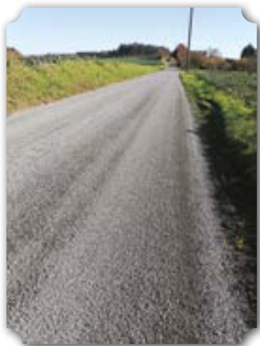
Le gravillonnage de la rue de Lisborde et de la route de Glatigné.
